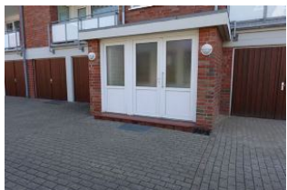
Der Eingang des Hauses mit einer Stufe
