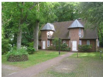
Das Haus Gmelinstr. 19c Die Wohnung befindet sich rechts
