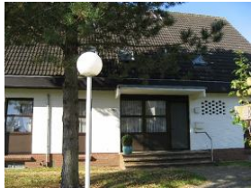
Die Haustür des Hauses Gmelinstr. 28 Haus 5
