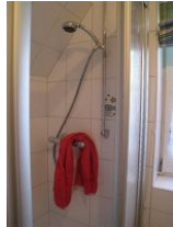
.. mit Dusche und ..
