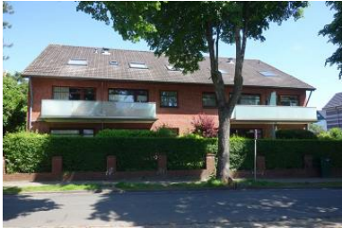
Die Aussenansicht des Hauses Feldstrasse 18
