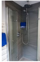
...die Duschkabine mit Echtglaswänden und Bodenablauf.
