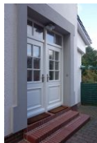
Die Haustüren der Villa Hansson, jede Wohnung verfügt über einen eigenen Eingang.
