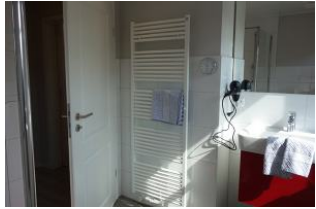
Das Bad mit Waschtisch, Handtuchheizung....
