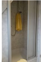
...und nicht zuletzt die Duschkabine.
