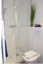
Die Dusche mit flacher Wanne, die Toilette
