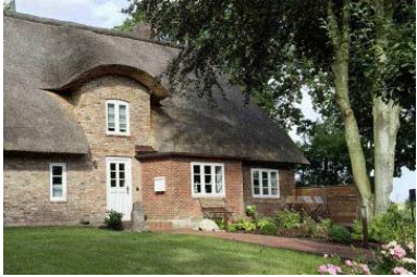
Das Haus WattGut in Oevenum
