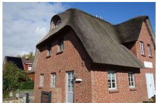
Der linke Eingang führt in das Haus 2
