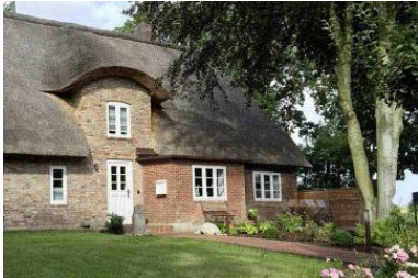
Das Haus WattGut in Oevenum
