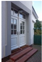
...die linke Haustür führt in die Wohnung 1
