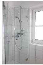
...Dusche, neu mit Glastür.
