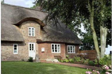
Das Haus WattGut in Oevenum
