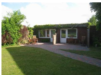
2 Bungalows bei Familie Carstensen, der rechte Eingang führt in die Wohnung 3
