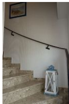
Das Treppenhaus führt zu beiden Wohnungen
