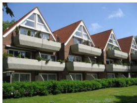
Die rückwärtige Ansicht des Hauses Olhörnweg 1 Die Balkone sind versetzt gebaut, so stört kein Gast den Anderen.
