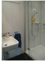
Das Duschbad im Obergeschoss
