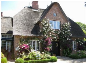
Reethus 5, ein Hausteil mit Stil.
