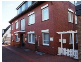
Ansicht Haus Teunis Mühlensstrasse
