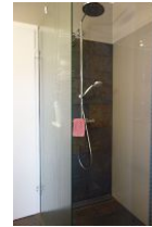
...und bodengleicher Dusche
