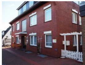
Ansicht Haus Teunis Mühlensstrasse
