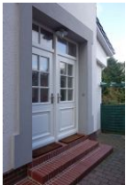
...die linke Haustür führt in die Wohnung 1
