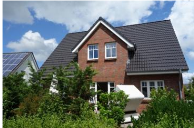
Das Haus Flurstrasse 28
