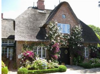
Reethus 5, ein Hausteil mit Stil.
