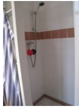
...die gemauerte Dusche, die zwei Handbrausen bereit hält...
