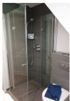
...und Duschkabine, aus Echtglas, sehr bequem: die Glaswand ist komplett weg zu klappen.
