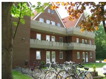
Das Haus Olhörnweg 1 Die Wohnung 15 befindet sich 1.OG
