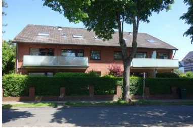
Die Aussenansicht des Hauses Feldstrasse 18
