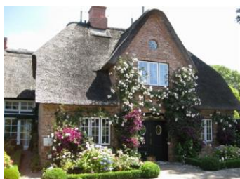
Reethus 5, ein Hausteil mit Stil.
