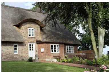
Das Haus WattGut in Oevenum
