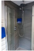
...die Duschkabine mit Echtglaswänden und Bodenablauf.
