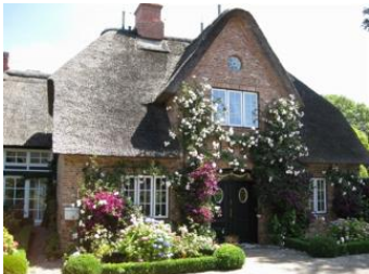
Reethus 5, ein Hausteil mit Stil.
