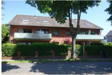
Die Aussenansicht des Hauses Feldstr. 18 in Wyk
