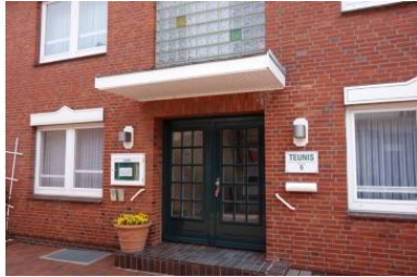
Das Haus Teunis in der Mühlenstrasse 9 / Ecke Carl - Häberlin - Strasse
