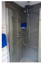
...die Duschkabine mit Echtglaswänden und Bodenablauf.
