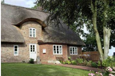
Das Haus WattGut in Oevenum
