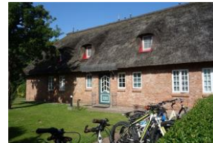
Der Eingang an der Seite führt zu den Wohnungen 1, 2, 4 und 5, hier befindet sich auch der Fahrradparkplatz
