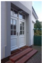
...die linke Haustür führt in die Wohnung 1
