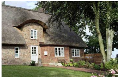
Das Haus WattGut in Oevenum
