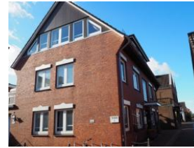
Ansicht Haus Teunis Carl-Häberlin-Str. Der Eingang ins Haus befindet sich rechts am Haus, die Garageneinfahrt links am Haus
