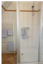
Die Duschkabine und Handtuchheizung
