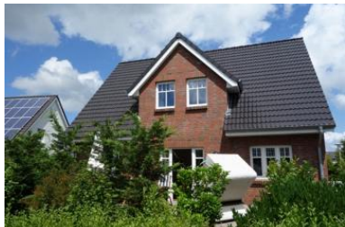
Das Haus Flurstrasse 28
