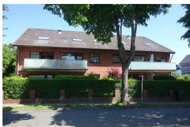
Die Aussenansicht des Hauses Feldstr. 18 in Wyk
