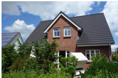
Das Haus Flurstrasse 28
