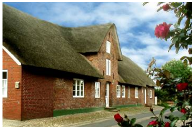
Das Haus "Welkimen tūs" in Oldsum Eingang zur Wohnung "Tradition"
