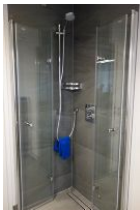
...und Dusche mit Echtglaswand, die komplett weg geklappt werden kann.
