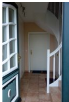
Der Eingang zur Wohnung 3
